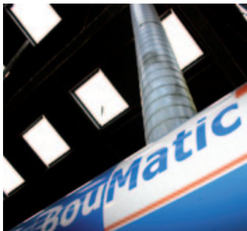
Met behulp van een ventilator wordt de lucht in de technische ruimte ververs.
