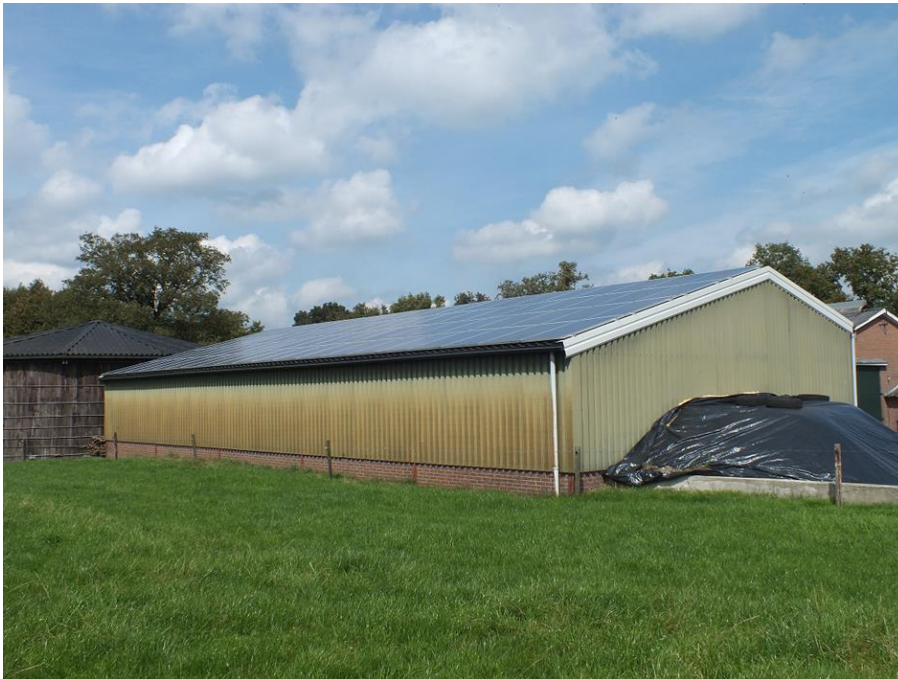
Schuur met zonnepanelen bij boerderij. Foto: S. Verzandvoort.
