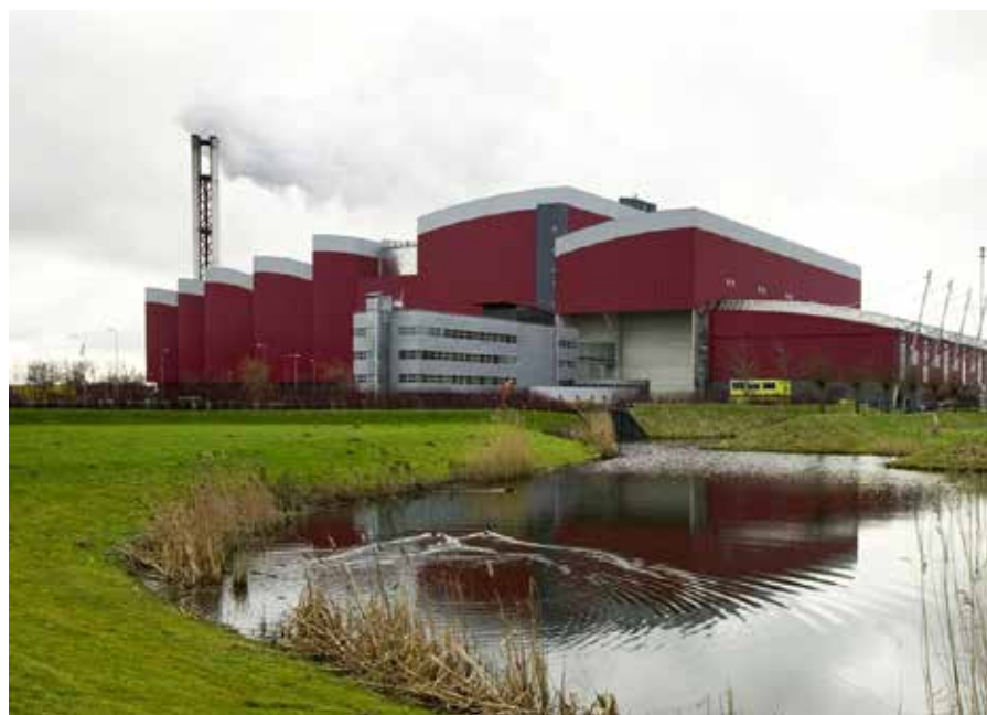
Vuilverbrandingsinstallatie in Alkmaar
