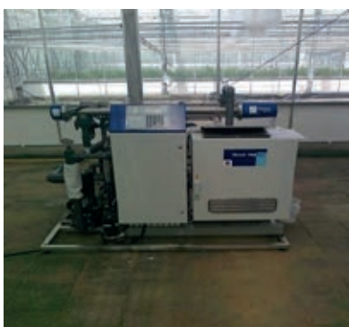
Figuur II.2 a Peroxide wordt toegevoegd aan de waterstroom, waar het onder invloed van UV-licht wordt omgezet in hydroxyl-radicalen, die reageren met de GBM. b. H 2 O 2 -MDUV opstelling van Priva c. H 2 O 2 -LDUV opstelling van HortiMaX.
