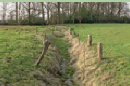
3.5a Situatie voor de ingreep: de sloot is diep ingesneden en ontwaterd de directe omgeving (Bron van de Burger)
