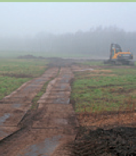
3.3 Werken met rijplaten voorkomt insporing (Perceel Weersink in het Dal van de Mosbeek)
