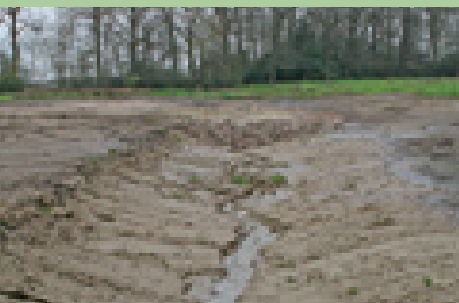
3.5b Situatie na de ingreep: de slootbodem is opgehoogd en op een aantal plekken zijn keiendrempels aangelegd (Bron van de Burger)
