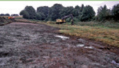
3.10a Uitvoering van de werkzaamheden in 2003 (Dal van de Kersberg)
