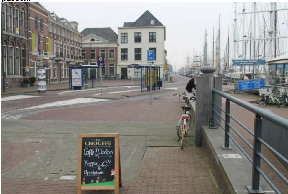
Figuur 1.2 Klepkering in de straat in Kampen (grijze vlak). Op de plek van het hek kunnen bovendien schotten worden geplaatst. In de paal is de gleuf te zien waar de schotten in passen.
