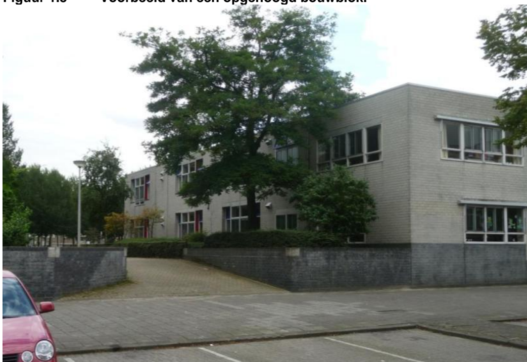
Figuur 1.3 Voorbeeld van een opgehoogd bouwblok.
