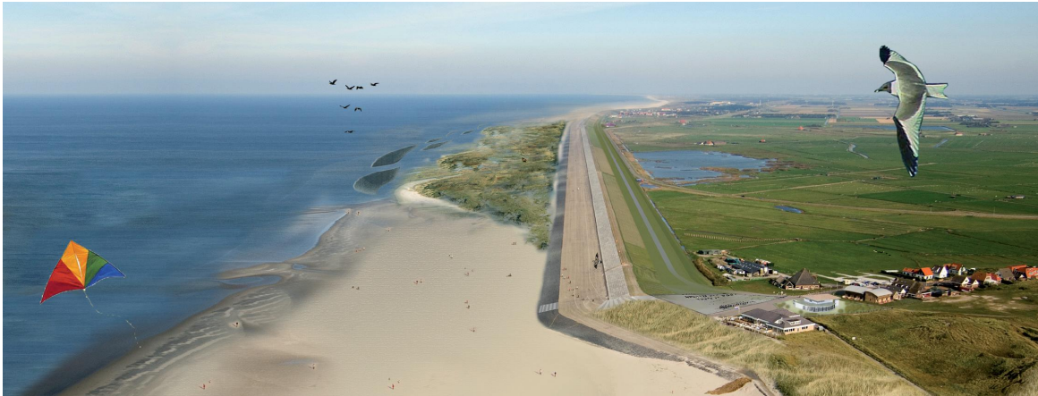
Figuur 4.8 Artist impression van de met een zandsuppletie verbrede en versterkte Hondsbossche zeewering (uit Factsheet Kust op Kracht, 2009)
