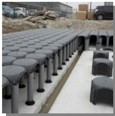
Waterberging onder de Parallelweg in Schiedam ( www.Schiedam.nl )
