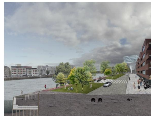
'Superdijk' langs de Nassaukade (KvK HSRR3.1, 2010)
