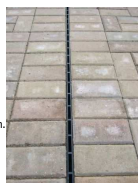
Water wordt opgevangen onder de bestrating en verdwijnt de bodem in.
