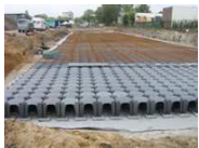
Water wordt opgevangen onder de bestrating en verdwijnt de bodem in.
