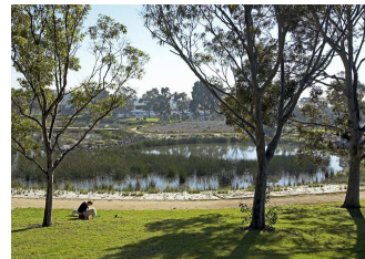
17. Royal Park wetland. Regenwater afgestroomd van daken, wegen en uit goten wordt opgevangen en in het wetland gezuiverd. Het wordt gebruikt om sportvelden en gras in het park mee te besproeien.
