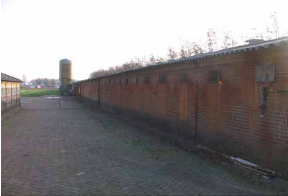
De beide stallen. Op de voorgrond de controlestal, achter de ScanFeederstal.
