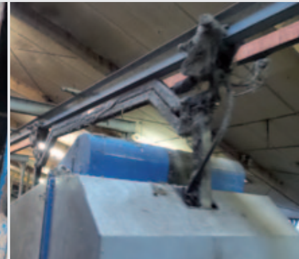
De robot hangt aan een rail. Het ophangmechanisme is uitgerust met weegcellen zodat de hoeveelheid voer nauwkeurig wordt bijgehouden.
