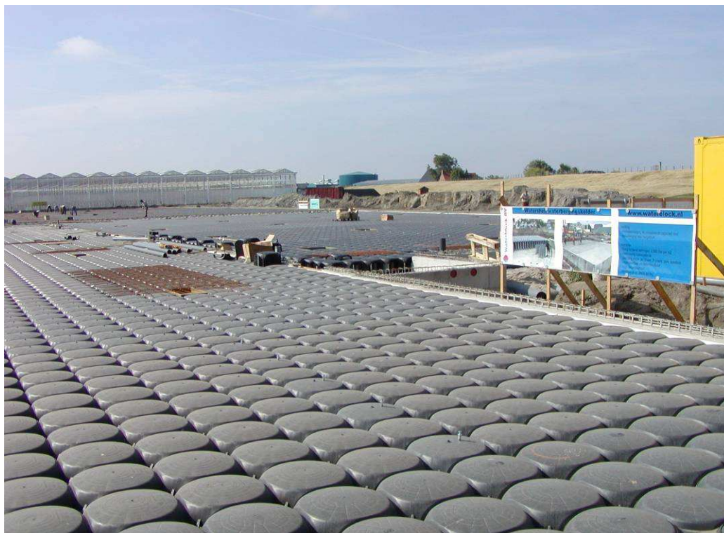
Figuur 4: Bergingskelder in uitvoering.
