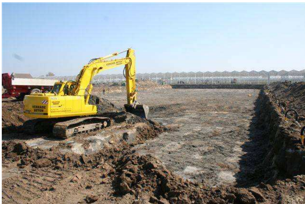
Figuur 2: Ontgraving t.b.v. aanleg kelder.
