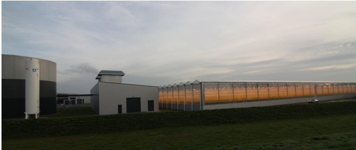
Belichting, wk-installaties, warmte buffer en externe CO 2
