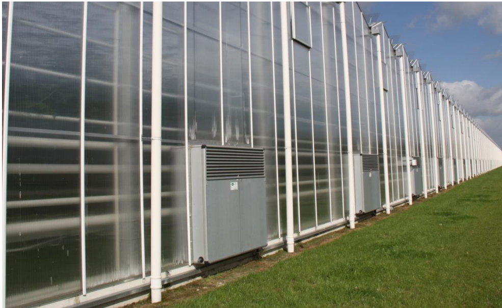
Luchtbehandelingskasten in gevel in combinatie met Het Nieuwe Telen
