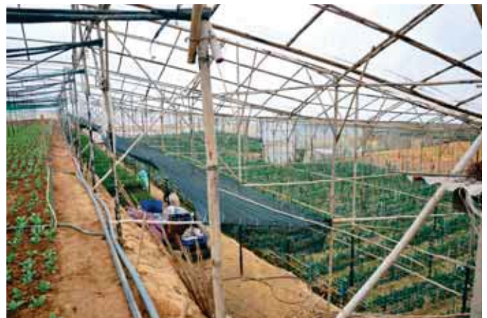
▲ Naast ijzer wordt ook bamboe veel gebruikt voor de constructie van plastic serres
