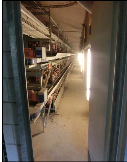
Kipvrij gangpad tussen de buitenste systeemrij en de rechter zijgevel. Aan/in de wand zijn de lampen en inlaatventielen zichtbaar
