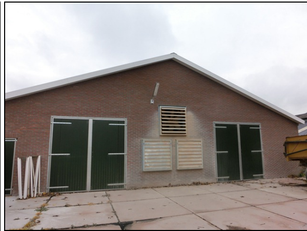
Achtergevel met drie ventilatoren
