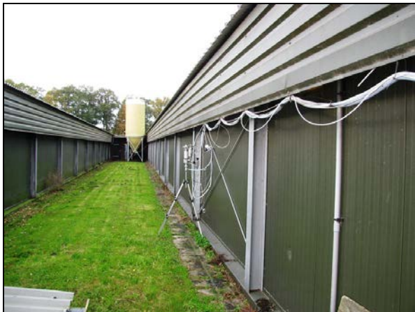
Meting van de binnenkomende lucht
