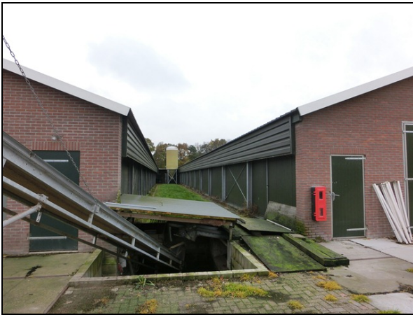
Zijgevel met inlaatventielen onder winddrukcap
