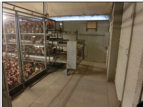
Ruimte tussen het einde van een systeemrij en de achtergevel. In de zijgevel is de lichtstraat en een inlaatventiel zichtbaar
