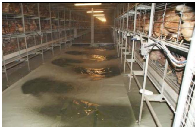
Figuur 10 Foto van het sproeibeeld bij 2,0 bar oliedruk en 1,5 bar luchtdruk. De nozzles zijn 'om en om' gemonteerd aan de staanders van de volièrestellingen en vernevelen naar de vloer in de richting van de stelling aan de overzijde.
