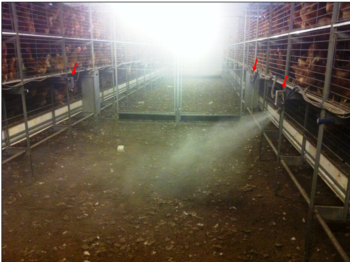
Detailfoto van het oliefilmsysteem in werking: aan de standers van de volièrestellingen zijn links en rechts ('om en om') vernevelkastjes gemonteerd (zie rode pijlen), welke één voor één de koolzaadolie met een kegelvormige sproeibeeld aanbrengen op de strooiselvloer.
