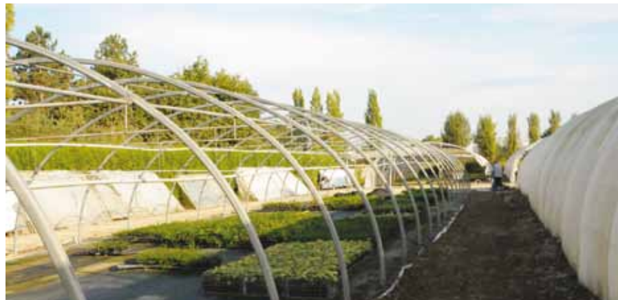
Renovatie van een tunnelkas. Plastic en draad worden vervangen.
