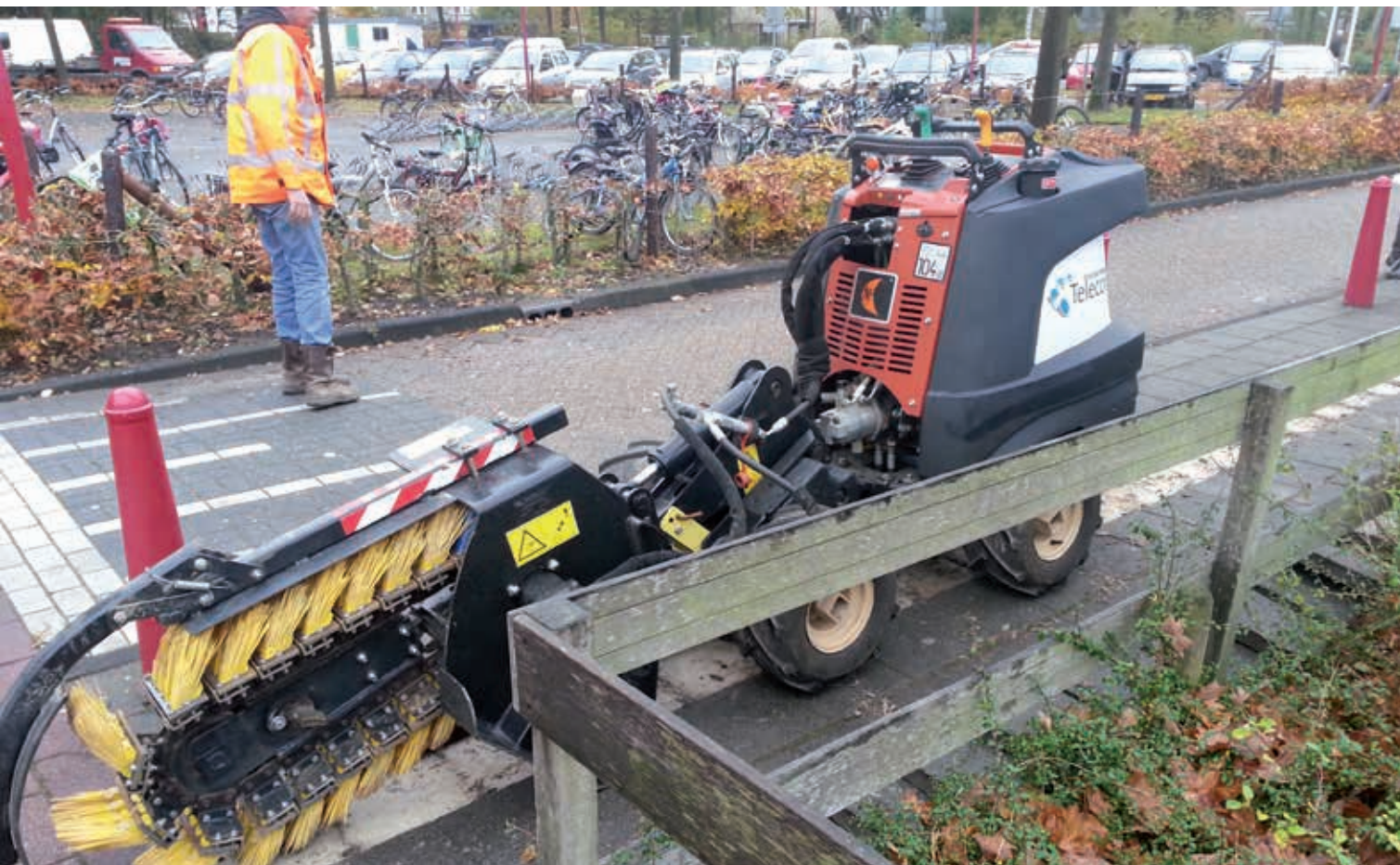
De werkzaamheden in Utrecht vorderen gestaag.
