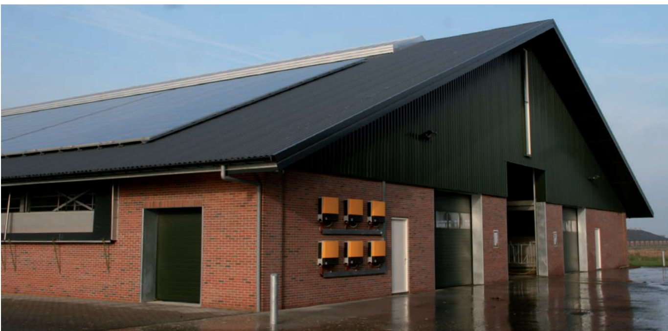
Met de installatie van 500 vierkante meter zonnepanelen op het dak van de nieuwe stal, is het bedrijf energieneutraal.
