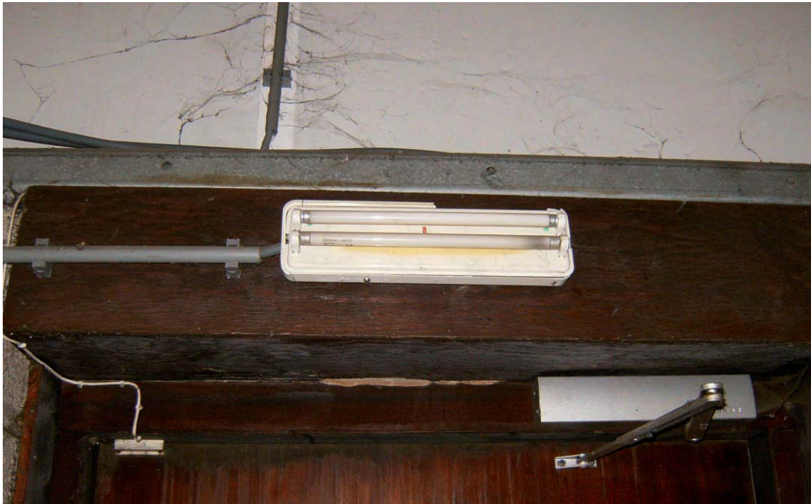
Zonder afdekkap kan stof direct in aanraking komen met de warmtebron, een risicovolle situatie.
