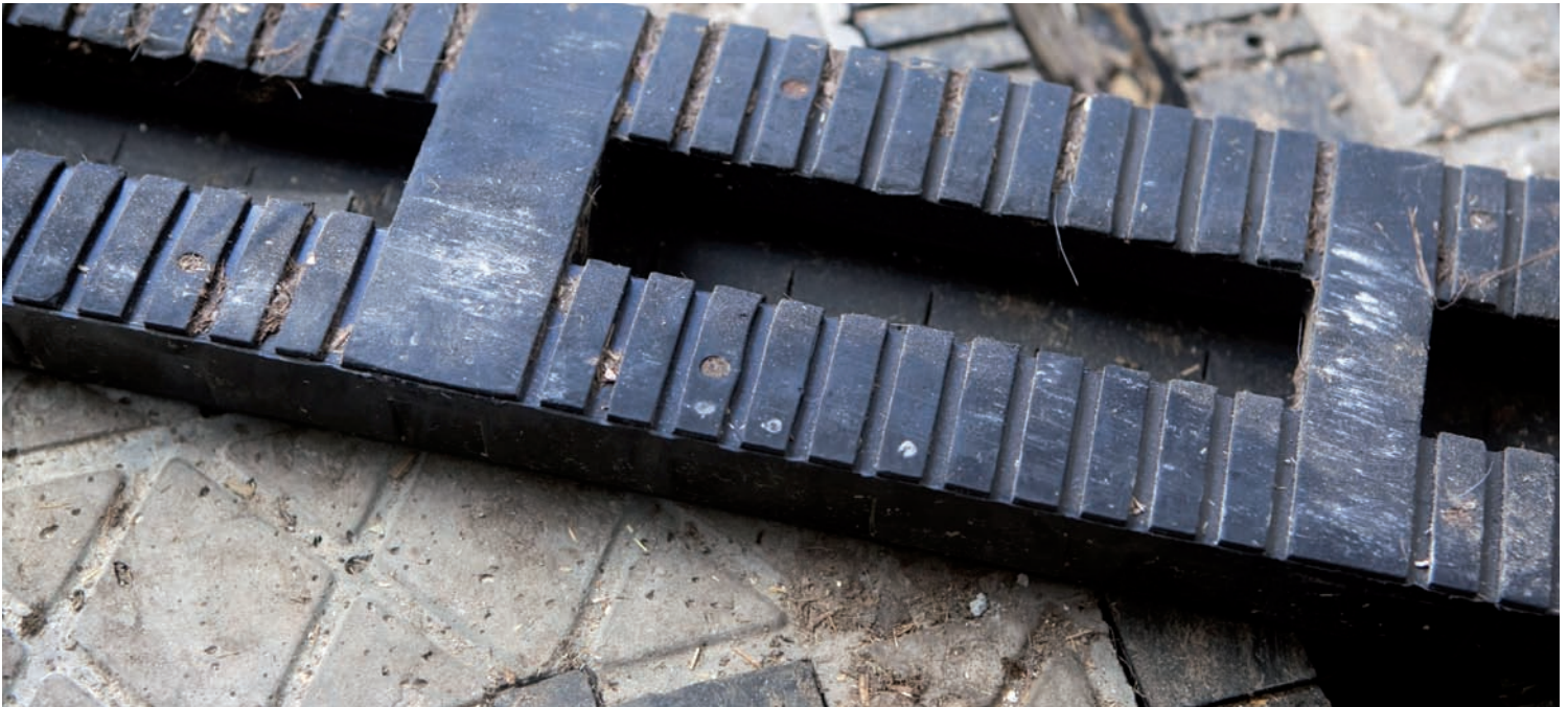
De ecovloer bestaat uit beton en rubberen elementen met kleppen. Als er voldoende mest op valt, gaat het klepje open en valt de mest in de kelder.
