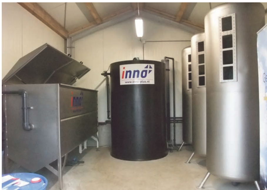
Biologische luchtwater, met rechts het nitrificatieproces en in het midden het identificatieproces.
