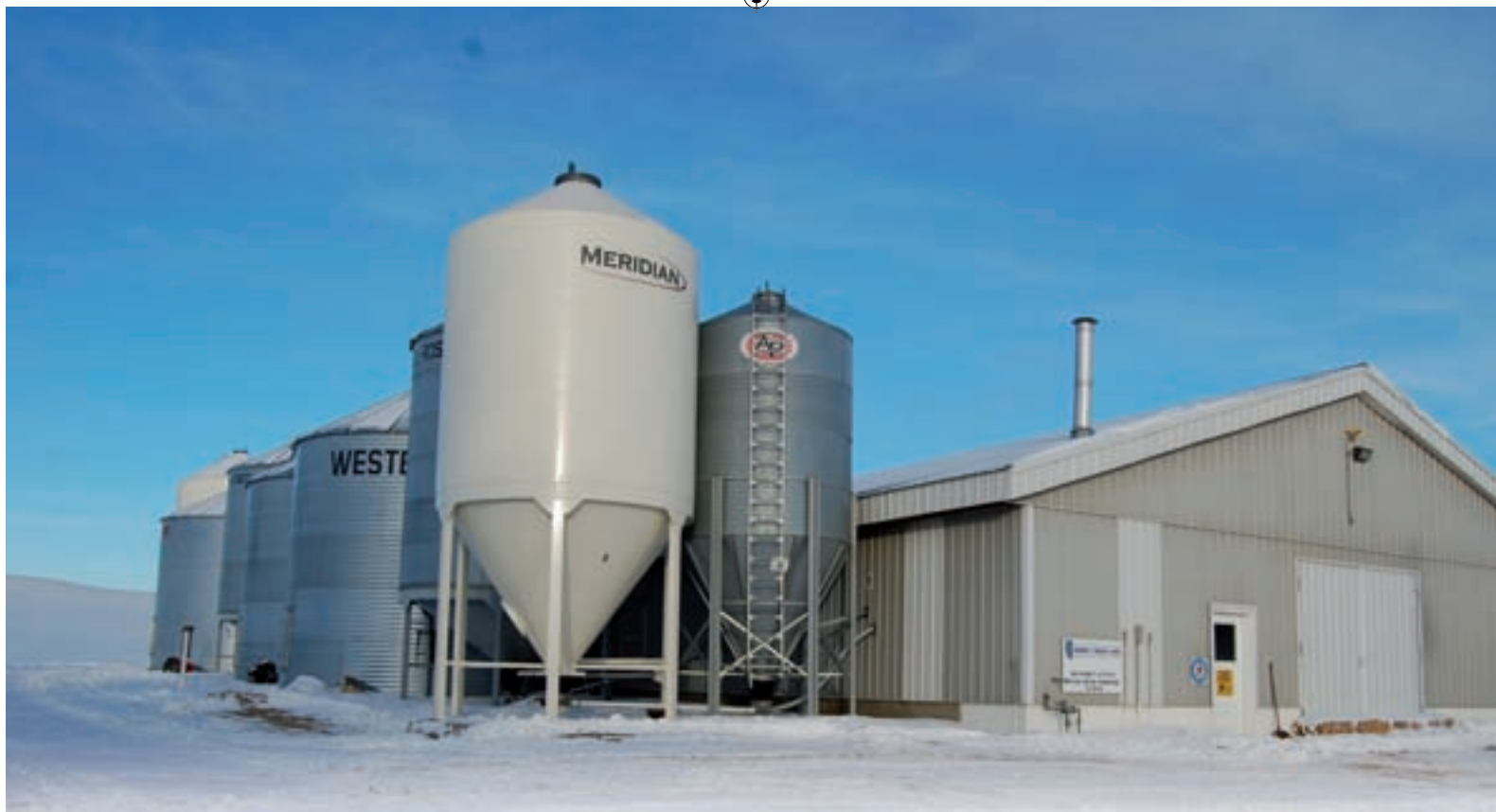
De voorste bins (silo's) met aangekocht voer en de eigen voertarwe zijn aangesloten op de computergestuurde menginstallatie in het voerlokaal.
