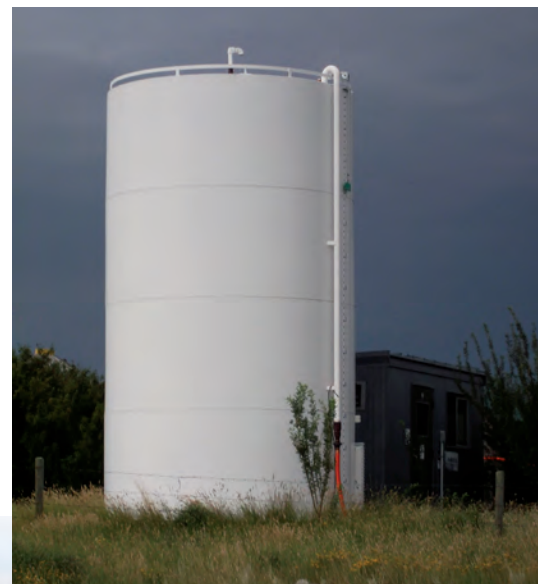
Om de dieren van vers water te voorzien, wordt water opgeslagen in een tank van 63.000 liter.
