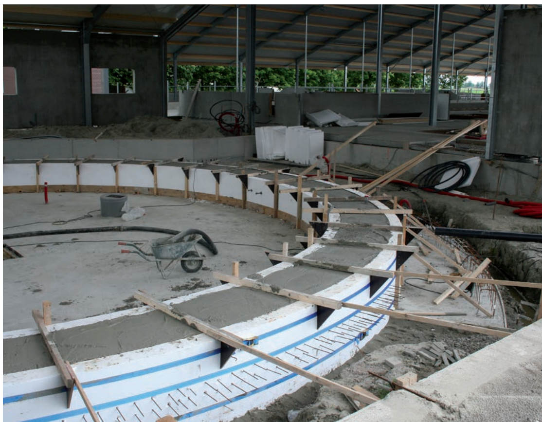
Nadat ook de binnenwand is geplaatst, wordt de bekisting volgestort met betonspecie (foto: Havadi).
