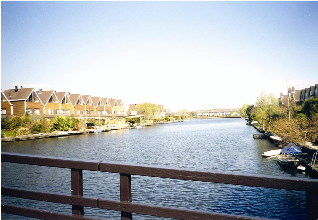
Foto 1: Een voorbeeld van een gewilde locatie met uitzicht op bruikbaar water aan de achterzijde in Zoetermeer.
