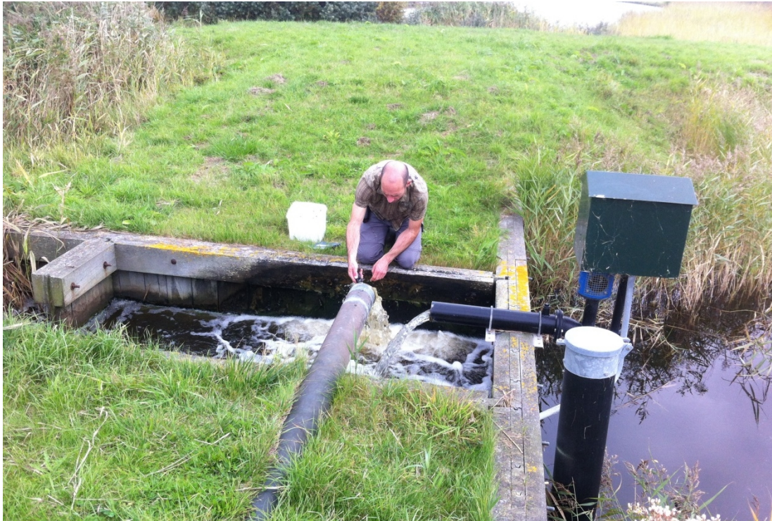
Inlaat natuurgebied Koudenhoek: menging van zoet en brak water tot gewenst chloridegehalte
