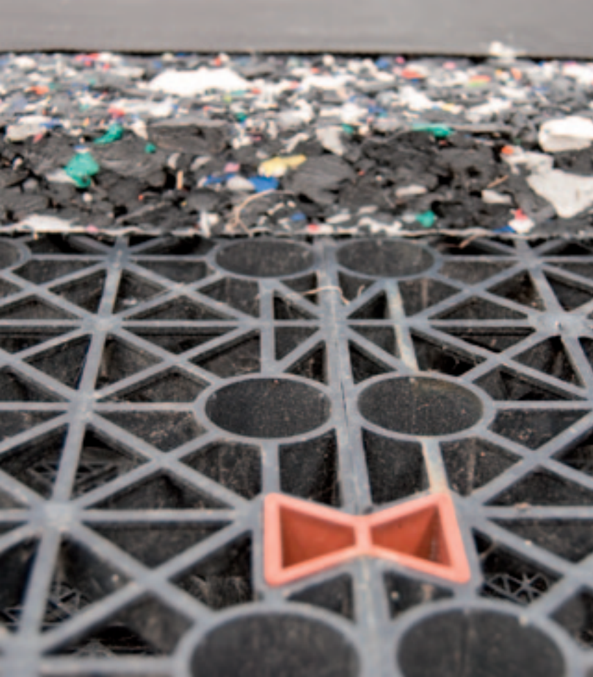
De opbouw van de vloer: op de zandbodem liggen de units op een vloeistofdicht doek. De units dragen de zachte foamlaag die is bedekt met de toplaag.
