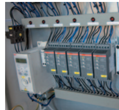
^ Storingindicatie Bij de PLC's vind je een aantal waarschuwingslampjes die een indicatie geven voor mogelijke storingsoorzaken.
