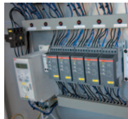
^ Storingindicatie Bij de PLC's vind je een aantal waarschuwingslampjes die een indicatie geven voor mogelijke storingsoorzaken.
