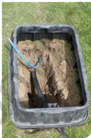
D.m.v. sleufloos draineren kunnen meerdere leidingen in één keer getrokken worden
