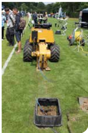
Sleufloos draineren beperkt de schade aan het gazon tot een minimum
