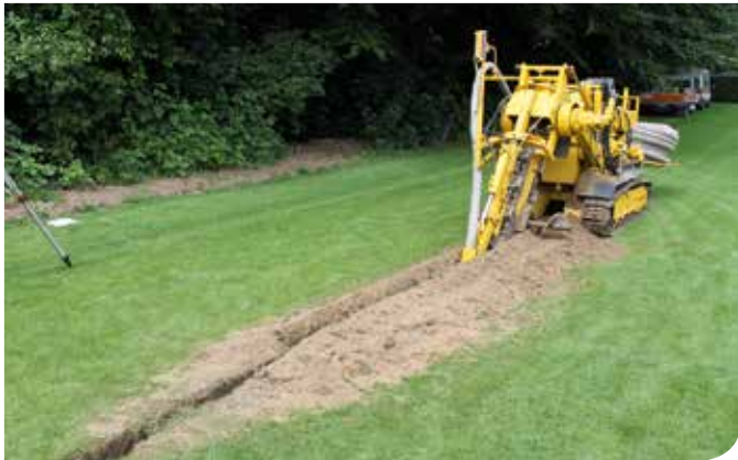
De lichtgewicht drainagemachine voorkomt bodemverdichting van tuinen en sportvelden
