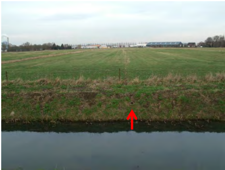
Figuur 6.10 Locatie 1 pijp die in verbinding staat met maaiveldgreppel.
