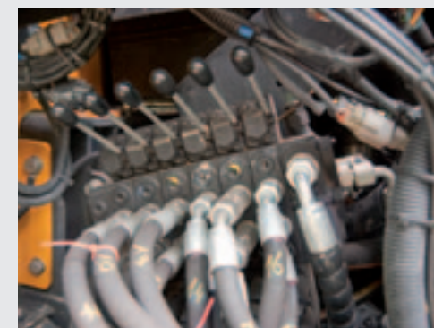
Bedienen van de machine kan als de elektronica het laat afweten direct via het ventielenblok. Het aantal functies is dan beperkt.
