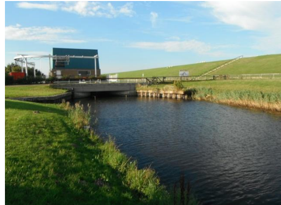
Locatie poldergemaal Ropta (polderzijde)
