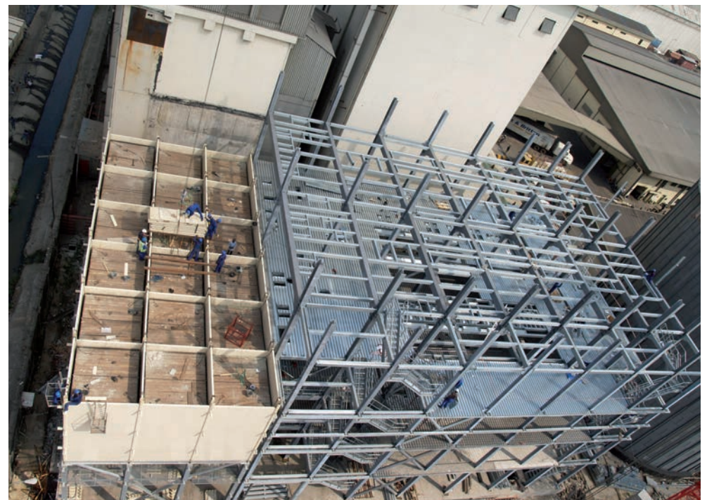
De opbouw van SCE-silo's in Nigeria.
