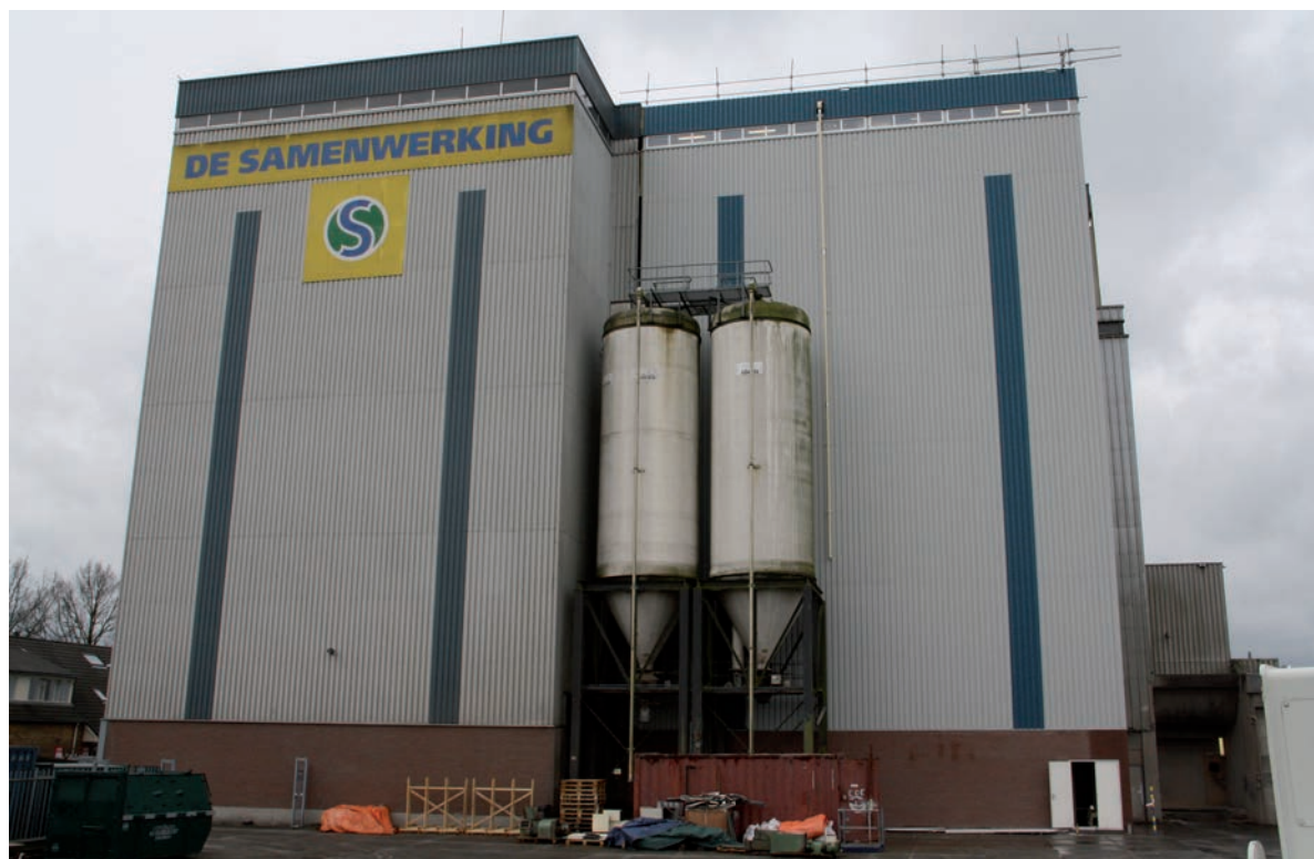
Rechts het nieuwe siloblok met een totale opslagcapaciteit van 750 ton, verdeeld over 10 cellen.
