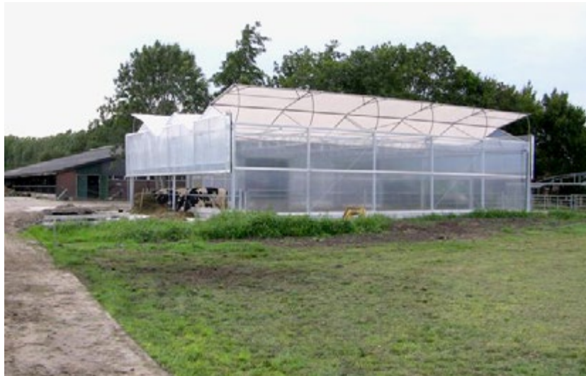
De eerste foliekas op proefbedrijf Zegveld met ventilatie door het dak
