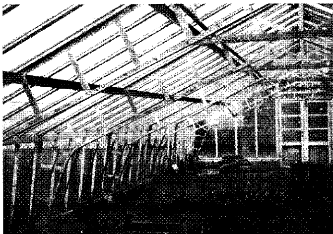
Afb. 3. Vakwerk spantconstructie in een groentekas met gehamerd glas te Mechelen
