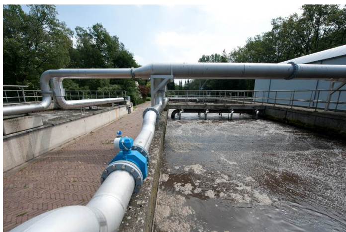
Figuur 5: Leidingwerk koppeling Megablock - rwzi
