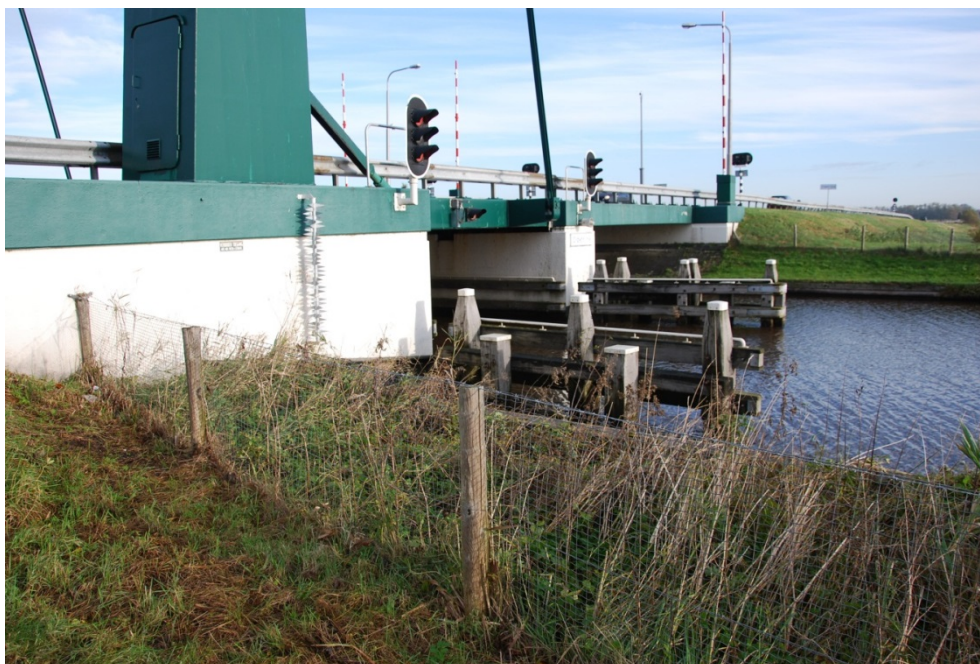
Figuur 5.3 Veilig raster met droge loopplank bij de Olderstrijnsterbrug in de Helomavaart (Fr). Locatie 11B; foto: Loek Kuiters.
