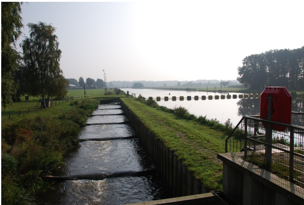
Figuur 5.6 Vistrappen bieden ook voor de otter prima mogelijkheden om stuwen veilig te passeren. Hier een vistrap in de Overijsselsche Vecht bij de stuw in Holt (Ov) (locatie 78); foto: Loek Kuiters.
