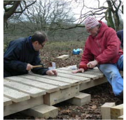
In het Strubben Kniphorstbosch, een archeologisch reservaat, is een mountainbikeroute gebouwd. De route, die vooral bestaat uit nieuwe aangelegde singletracks, is in overleg met de Rijksdienst voor het Cultureel Erfgoed en Staatsbosbeheer vooral aangelegd op geroerde gronden. Om over waardevolle karensproten te komen is door lokale mountainbikers een 'archeoduct' van eikenhout gebouwd. (foto Patrick Jansen, Probos)
