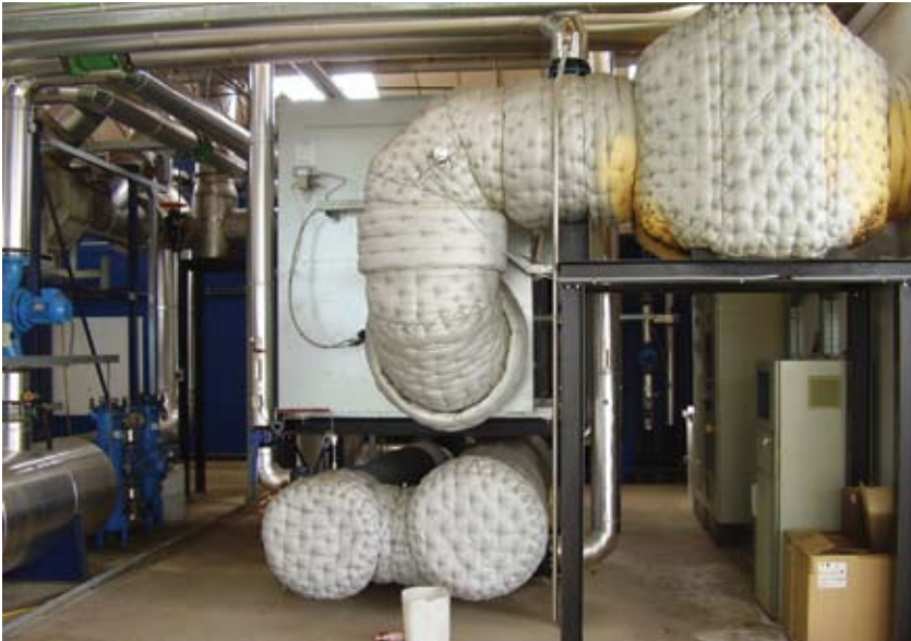
Rookgasreiniger wk-installatie
