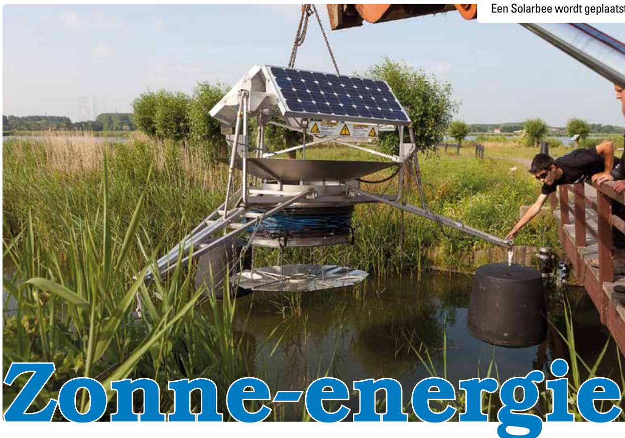
Een Solarbee wordt geplaatst.
