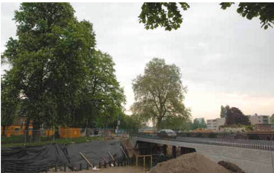
Stambescherming, bouwhekken, bodemvochtmonitoring, watergeefsystemen het ontbreekt de bomen aan niks.
