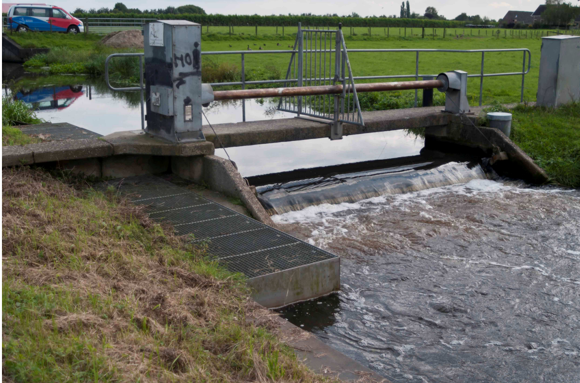
Foto 5. Traditionele 'De Wit' vispassage in Odijk. De Langbroekerwetering wordt hier met de Kromme Rijn in verbinding gebracht.
