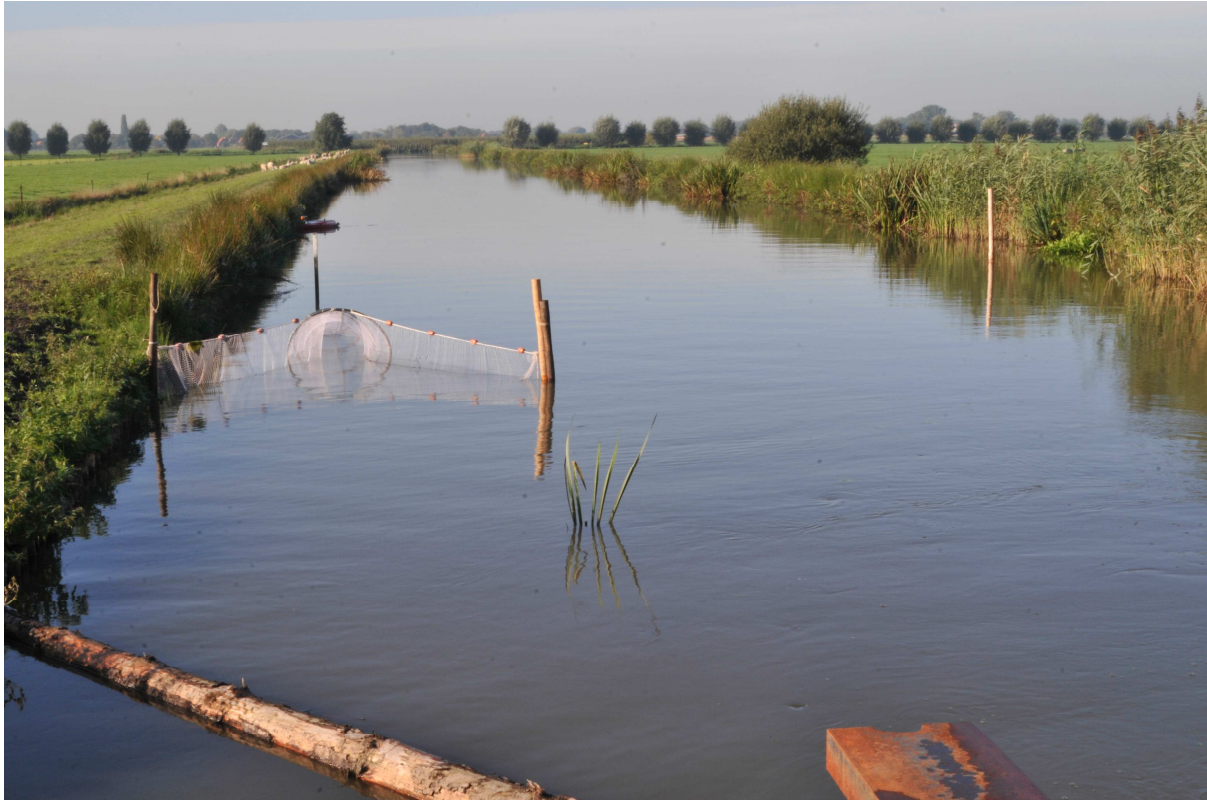
Foto 7. Op de voorgrond is een drijfbalk zichtbaar om drijvend vuil uit de “De Wit” vispassage te Kerkeland te weren. De fuik is bedoeld om vissen te vangen die de vistrap niet ingaan en terugzwemmen.
