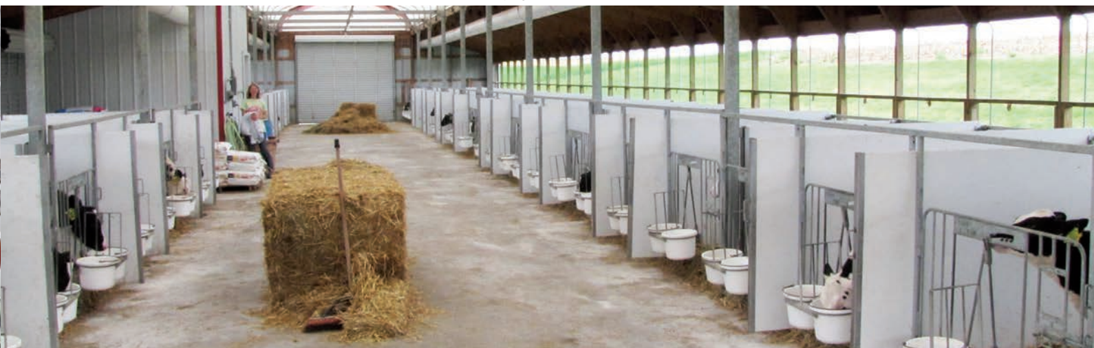
De bijzonder lichte kalverstal kan zowel mechanisch als natuurlijk geventileerd worden
