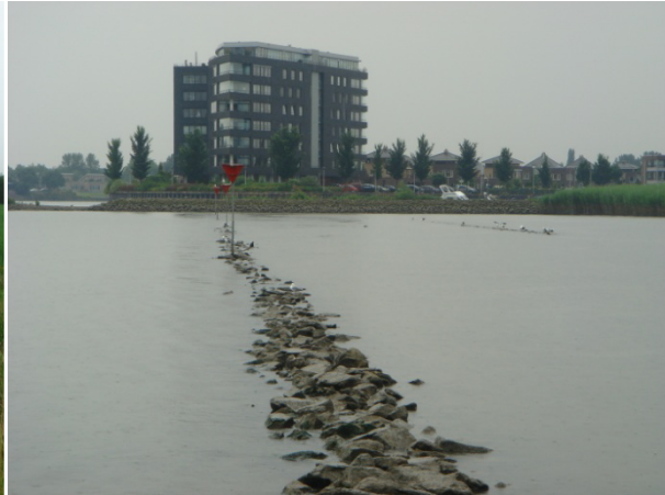
Vooroeververdediging met rode bakens op ingang en achterliggende dammetjes.
