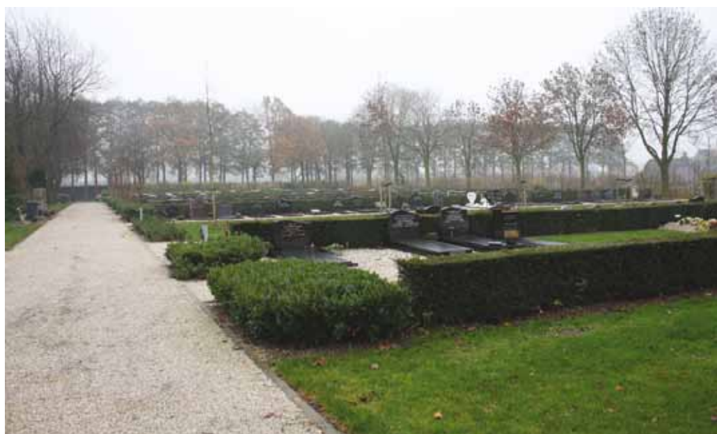
Halfverharding op begraafplaats Lienden.
