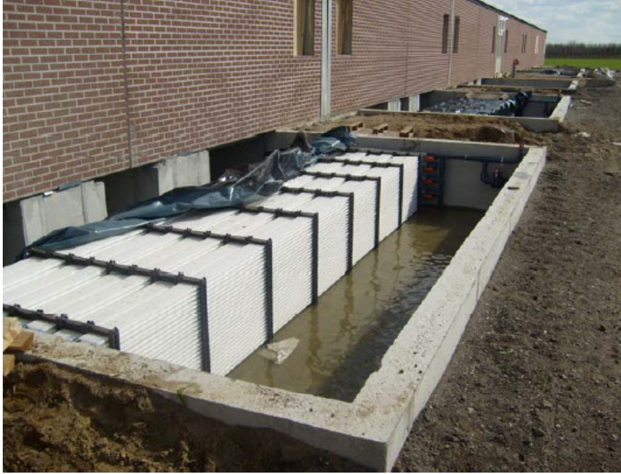
Figuur 2 Varkensstal in aanbouw met warmtewisselaar voor opwarmen/afkoelen binnenkomende lucht.
