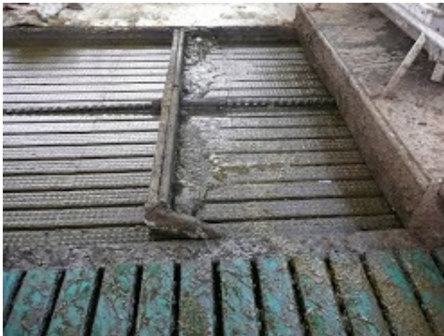
Figuur 8 Roostervloer en mestschuif.
