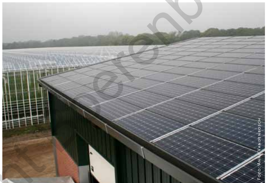
De installatie zal de nodige warmte ontvangen van de wkk- en biomassacentrale van het naastgelegen serrebedrijf. Op de loods rondom de drooginstallatie liggen geïntegreerde zonnepanelen.
