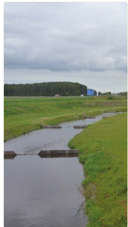
Vispassages zoals bij de Bult maken deel uit van het herstelproject voor de Westervoldse Aa.
